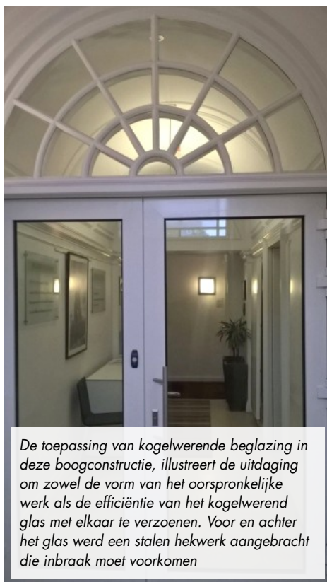
Metalen hekwerk als bijkomende maatregel voor het kogelwerend glas
