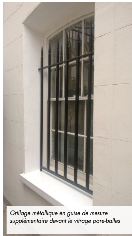
L'application de vitrage pare-balles dans cette construction en arc illustre le défi de concilier tant la forme de l'ouvrage initial que l'efficacité du vitrage pare-balles. Devant et derrière le verre, un grillage en acier a été placé devant éviter les effractions
