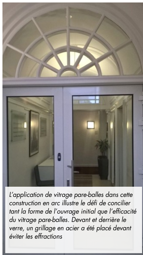
Grillage métallique en guise de mesure supplémentaire devant le vitrage pare-balles
