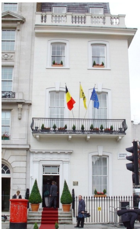
Vue de face de la Flanders House à Londres. Toutes les portes et fenêtres ont été remplacées par des alternatives pare-balles, sans trahir l'aspect classique du bâtiment
